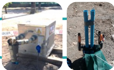
Figura 5: Test de Respuesta Térmica para medición de conductividad térmica del suelo
